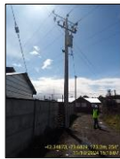
Aumento de potencia transformador de 15 a 25 Kva, sector Riacho Rural.
