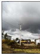
Instalación de nuevo transformador de 25 Kva, sector Mocopuli.
