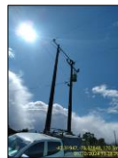
Aumento de potencia en transformador de 5 A 25 Kva, sector Chov San Juan.
