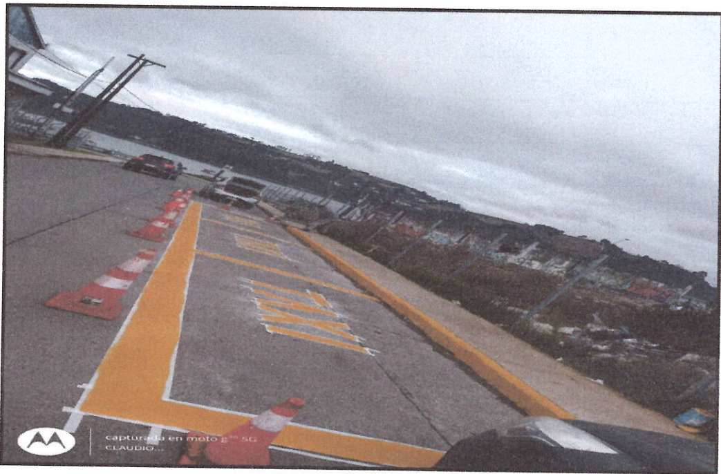
Calle Lautaro, intersección calle Fresia
